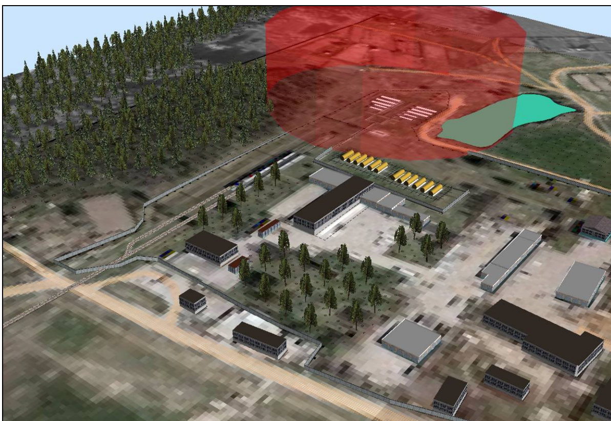
Рис. 6. Трехмерная модель строений типового КВО и зоны полных разрушений в результате ЧС
