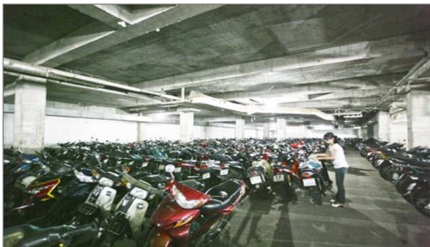
Рис. 2. Подземная автостоянка здания в г. Хошимине
