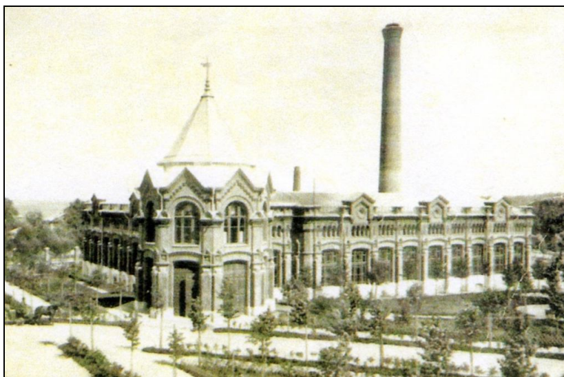
Рис. 3. Алексеевская водоканка. Алексеевское водоподъемное здание
