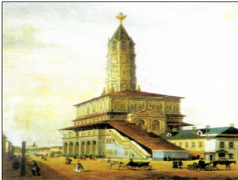
Рис. 2. Сухаревская водонапорная башня
