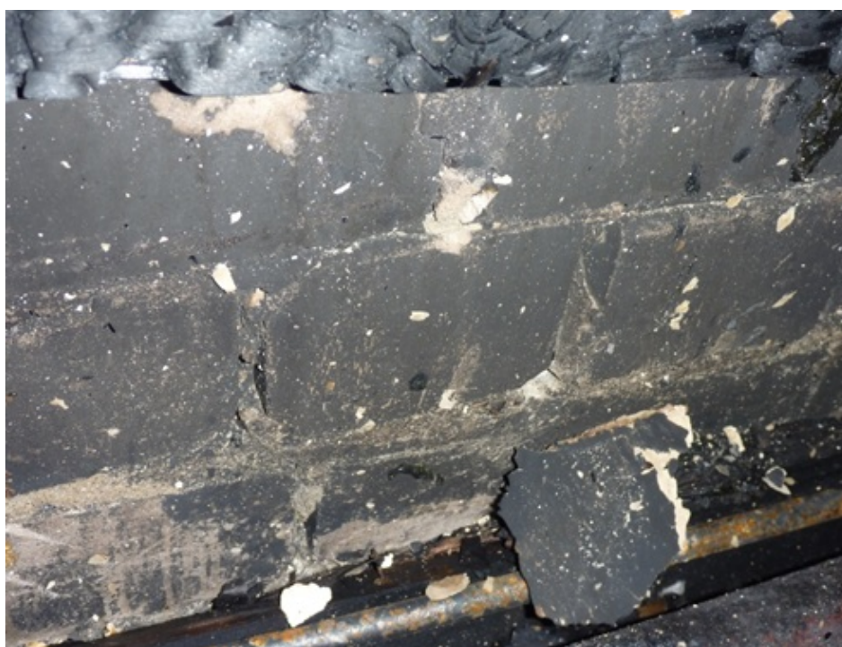
Рис. 2. Дегидратация поверхностного слоя силикатного кирпича
