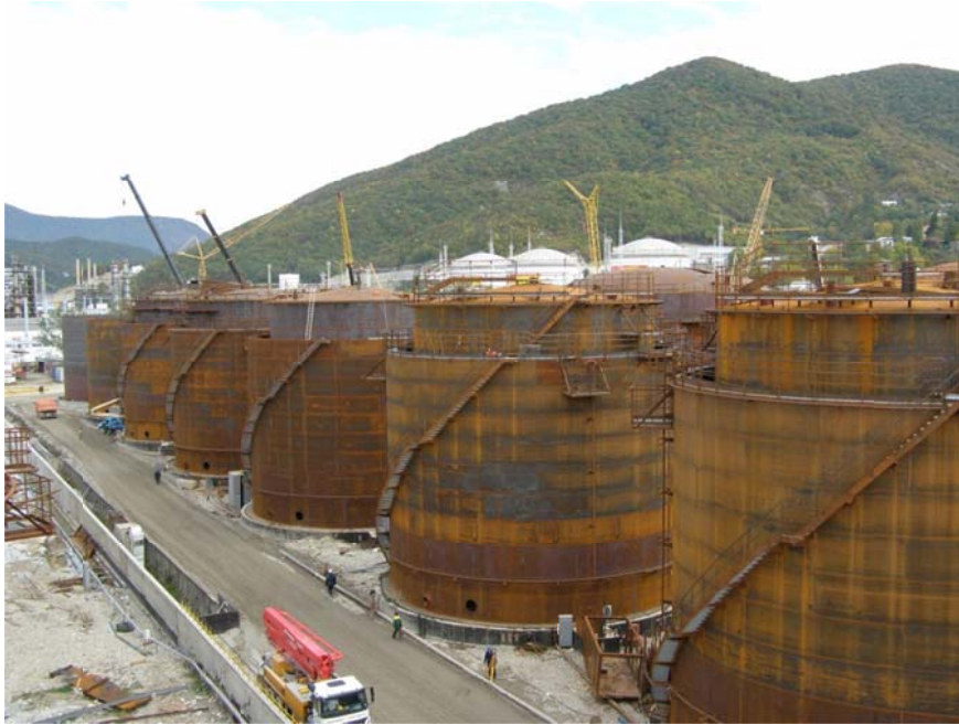
Рис. 1. Строительство группы резервуаров с защитной стенкой
