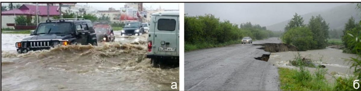
Рис. 2. Подтопление Магаданкой федеральной автодороги "Колыма" (Магадан – Якутск) в её начале (а). Размыв дорожного полотна боковой эрозией реки (б)
