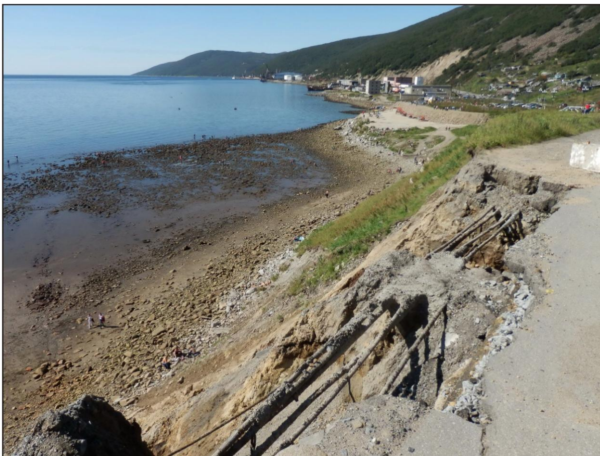
Рис. 13. Бровка ниши отрыва серии разновременных оползней на северном фланге Восточного клифа бух. Нагаева, размытая дополнительно кратковременным селем сошедшим в результате ливневых дождей июля 2014 г. Здесь средняя скорость отступления клифа в сторону суши под действием обвально-оползневых процессов, провоцируемых абразией, составляет около 2 м в год за 11-летний период наблюдений [1]. Ниша отрыва врезалась уже в обочину Портового шоссе, что угрожает обрывом связи города и области с Морским торговым портом
