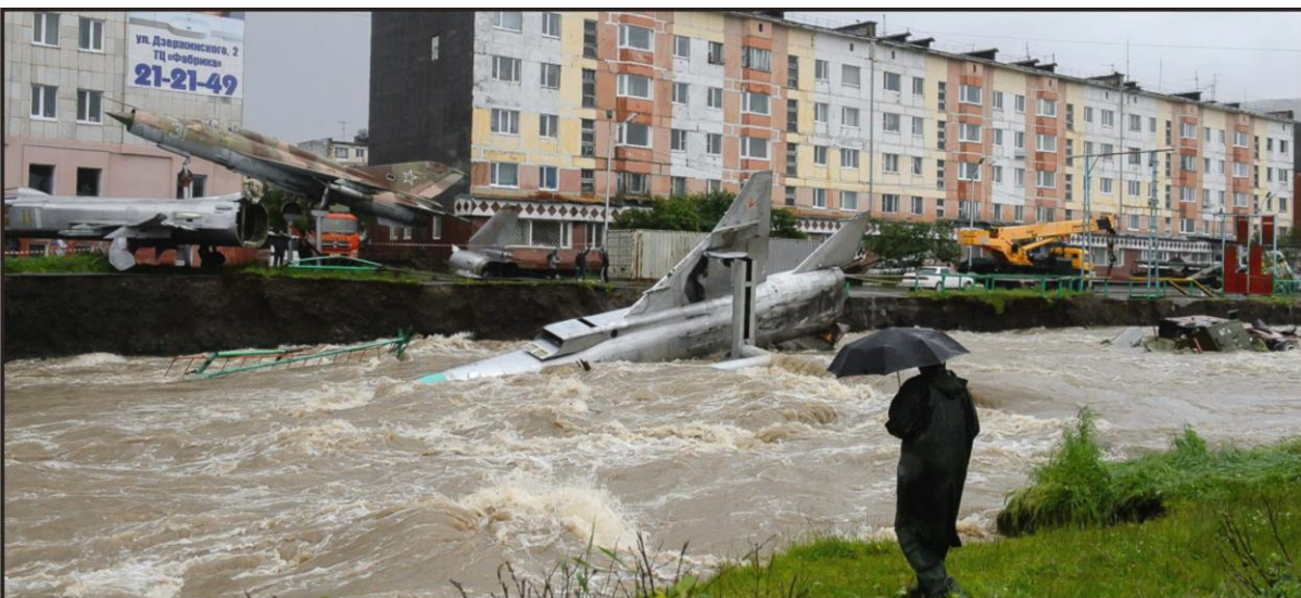
Рис. 3. Разрушение паводком музея военной техники на берегу р. Магаданка
