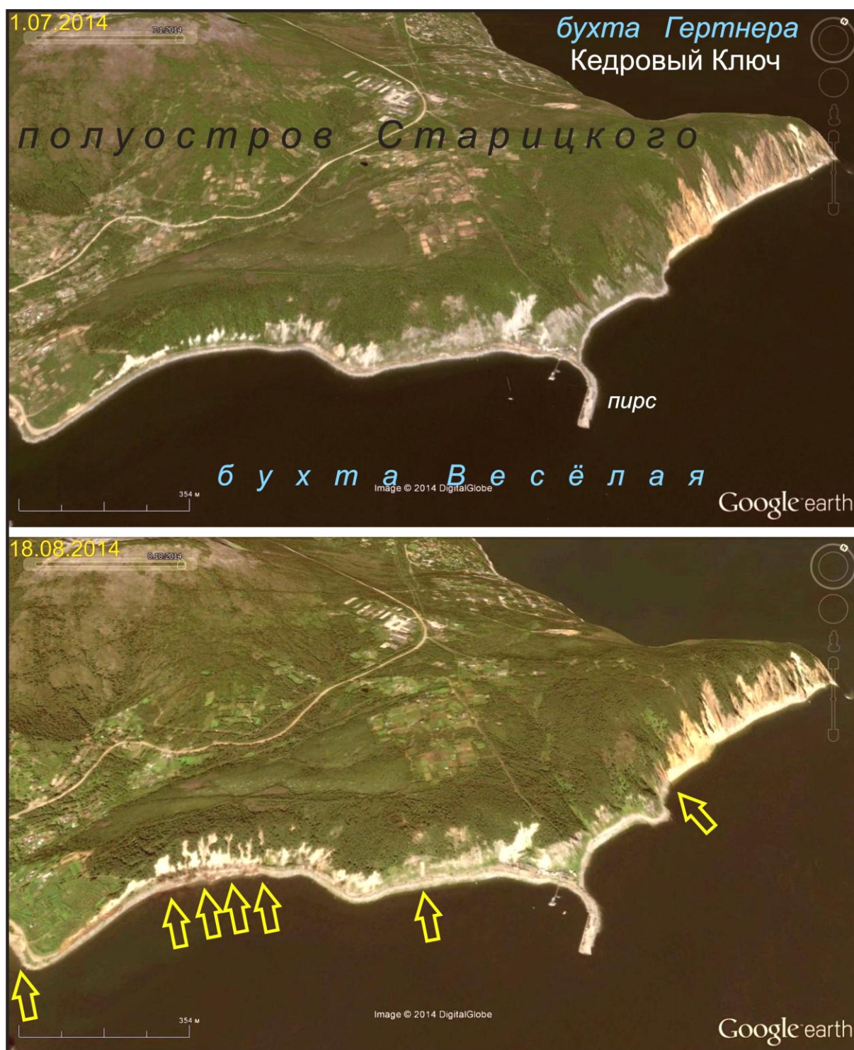
Рис. 10. Оползни размерами до 60-120 м на северо-западном берегу бух. Весёлая, перекрывшие дорогу к пирсу, расчищенную вскоре бульдозером
