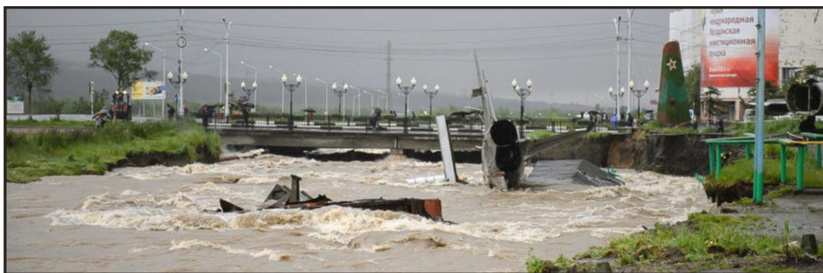
Рис. 5. Один из устоявших автомобильных мостов Магадана – на ул. Ленина в начале федеральной автодороги "Колыма"
