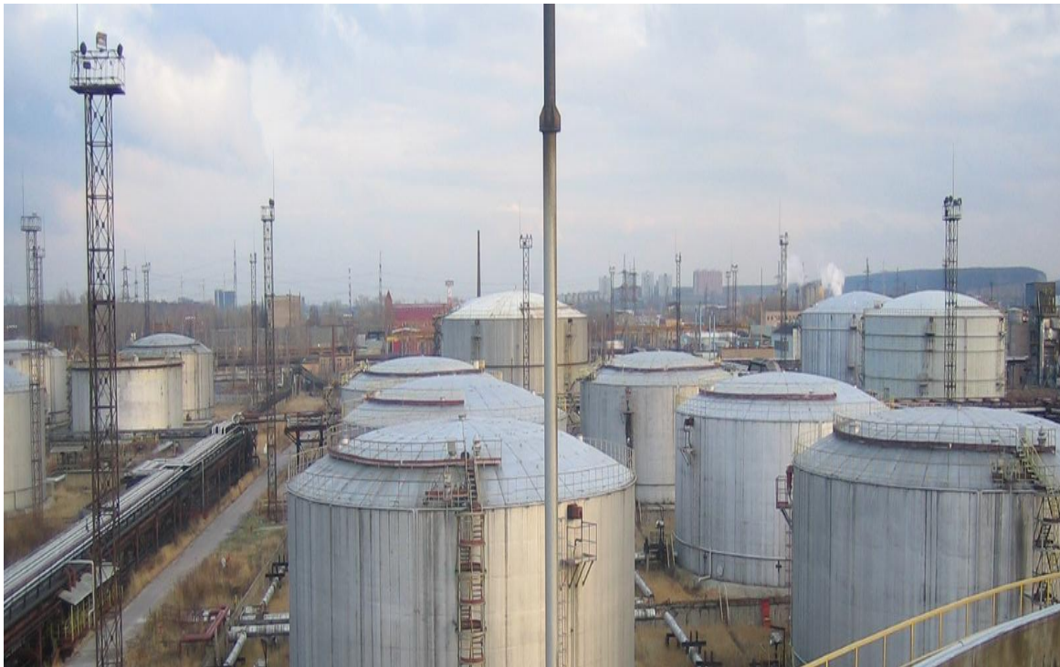
Рис. 1. Фрагмент резервуарного парка
