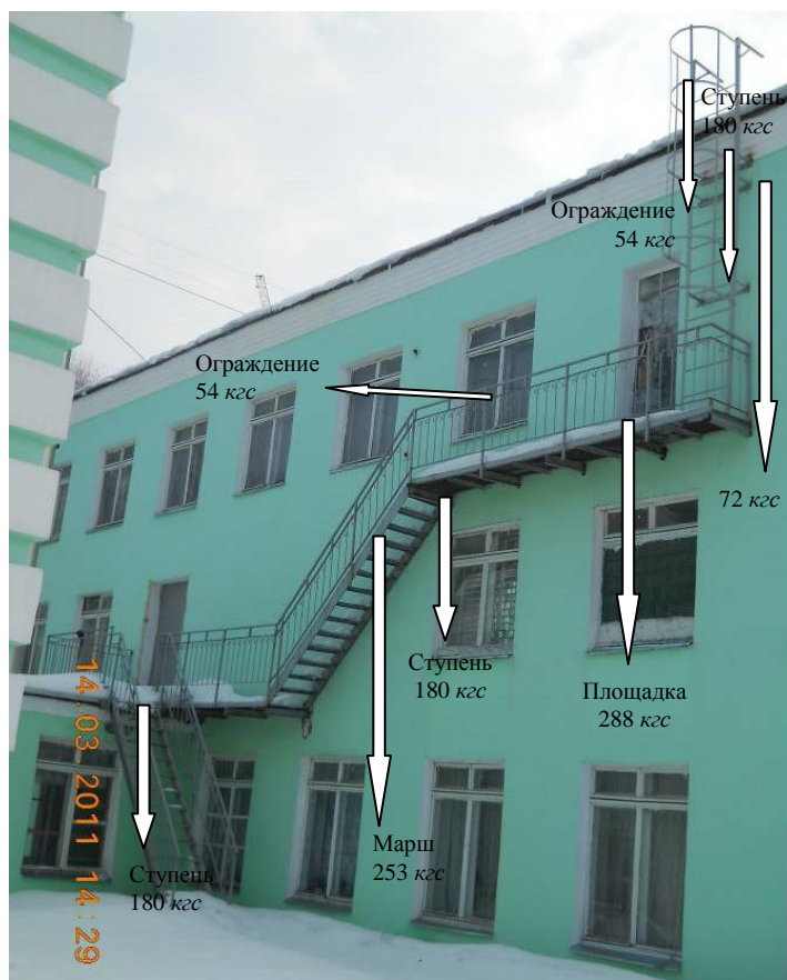
Рис. 1. Металлические пожарные маршевые и вертикальные лестницы
