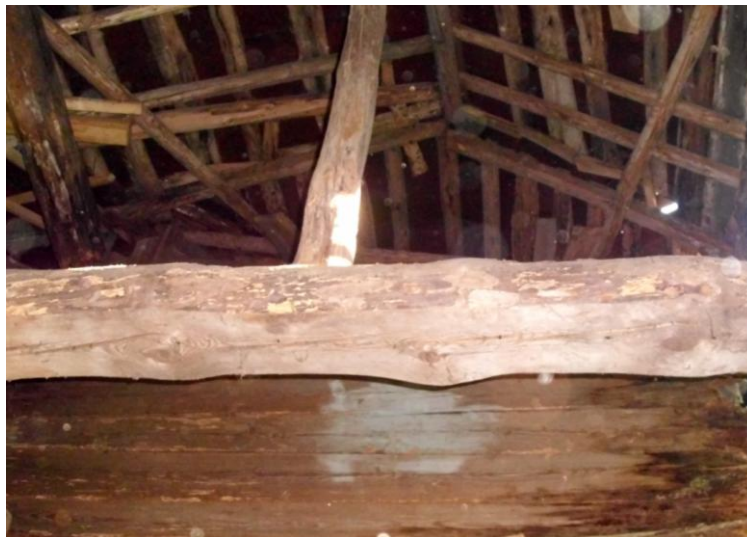
Рис. 1. Общий вид несущей деревянной балки и опорной стойки в церкви Николая Чудотворца (Брянская область), 1865 год постройки
