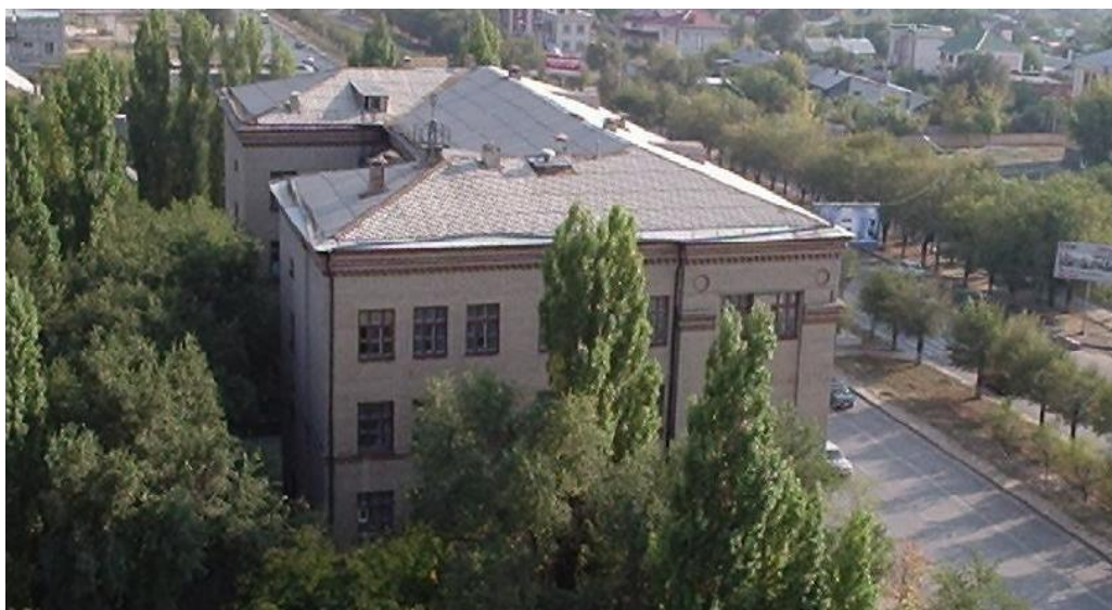
Рис. 3. Крыша средней школы № 43 г. Волгограда. Ремонт крыши произведён в 2013 г.
