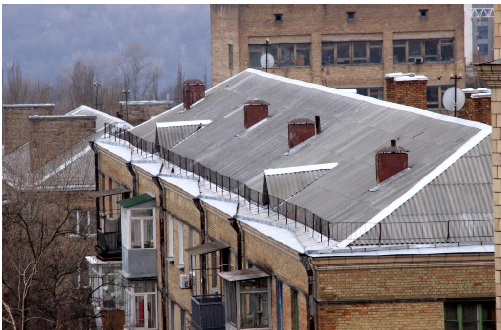
Рис. 2. Крыша жилого пятиэтажного дома. г. Тюмень. Ремонт крыши произведён в 2014 г.
