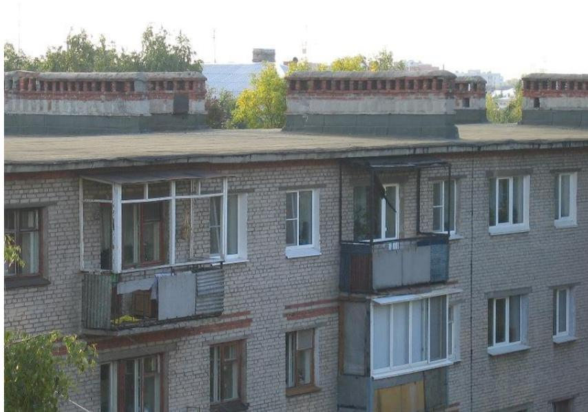
**Рис. 1.** Плоская крыша без защитного ограждения
