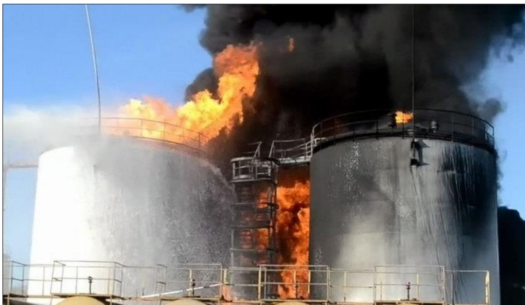
Рис. 1. Фрагмент распространения пожара в резервуарном парке нефтебазы ООО "Бытремстройматериалы" [4]
