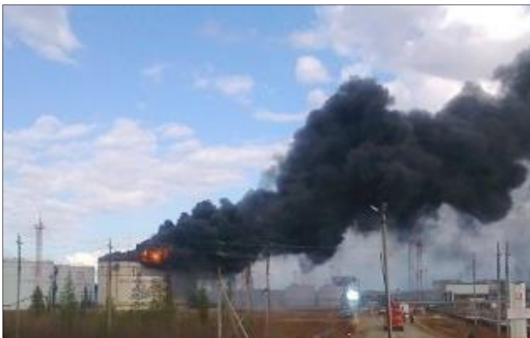
Рис. 2. Фрагмент пожара в РВС-5000 м 3 на территории ТПП "ЛУКОЙЛ-УсинскНефтегаз"
