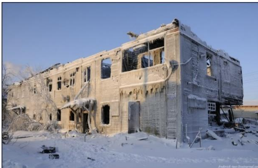
Рис. 3. Пример последствия пожара на объектах в условиях низких температур
