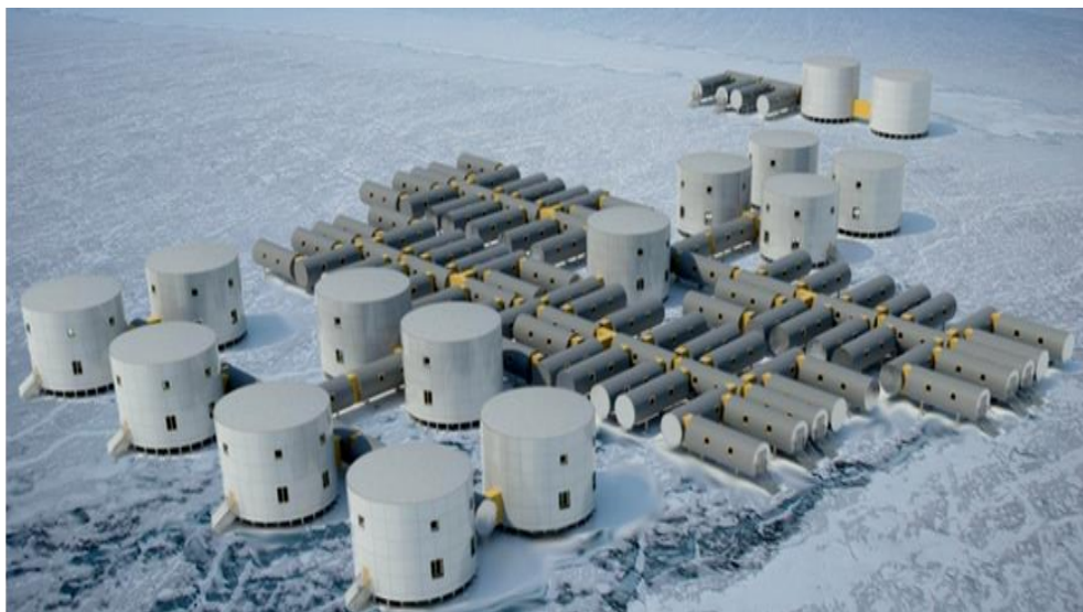
Рис. 2. Объекты в арктической зоне и на крайнем севере, выполненные на основе теплоизолированных модулей
