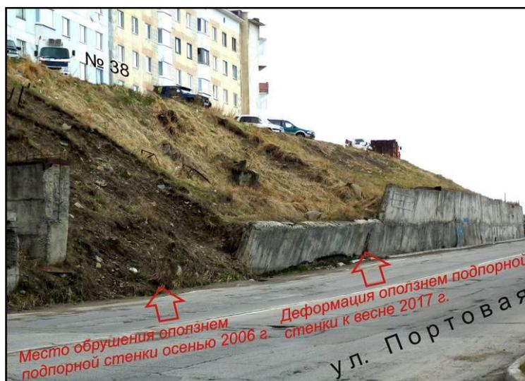
**Рис. 10.** Место обрушения в 2006 г. железобетонной подпорной стенки в Моргородке у дома № 38 по ул. Портовой.
