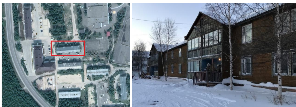
Рис. 1. Объект условного пожара
